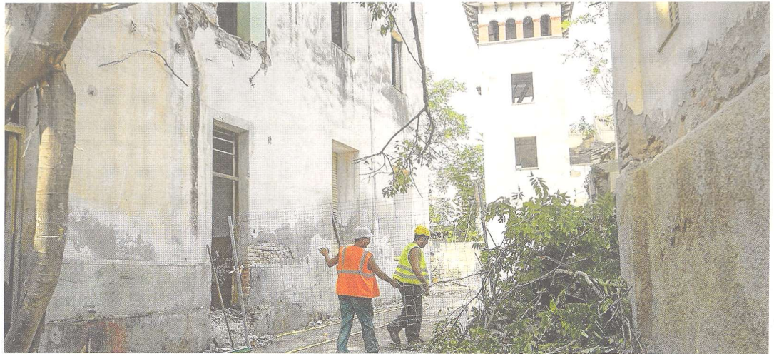
Dos operaris, treballant en els enderrocs previstos en l'obra, ahir. FOTO: JOAN REVILLAS
