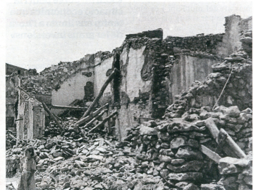
Cases destruïdes per les bombes. FOTO: REGIONES DEVASTADAS/ACBE
