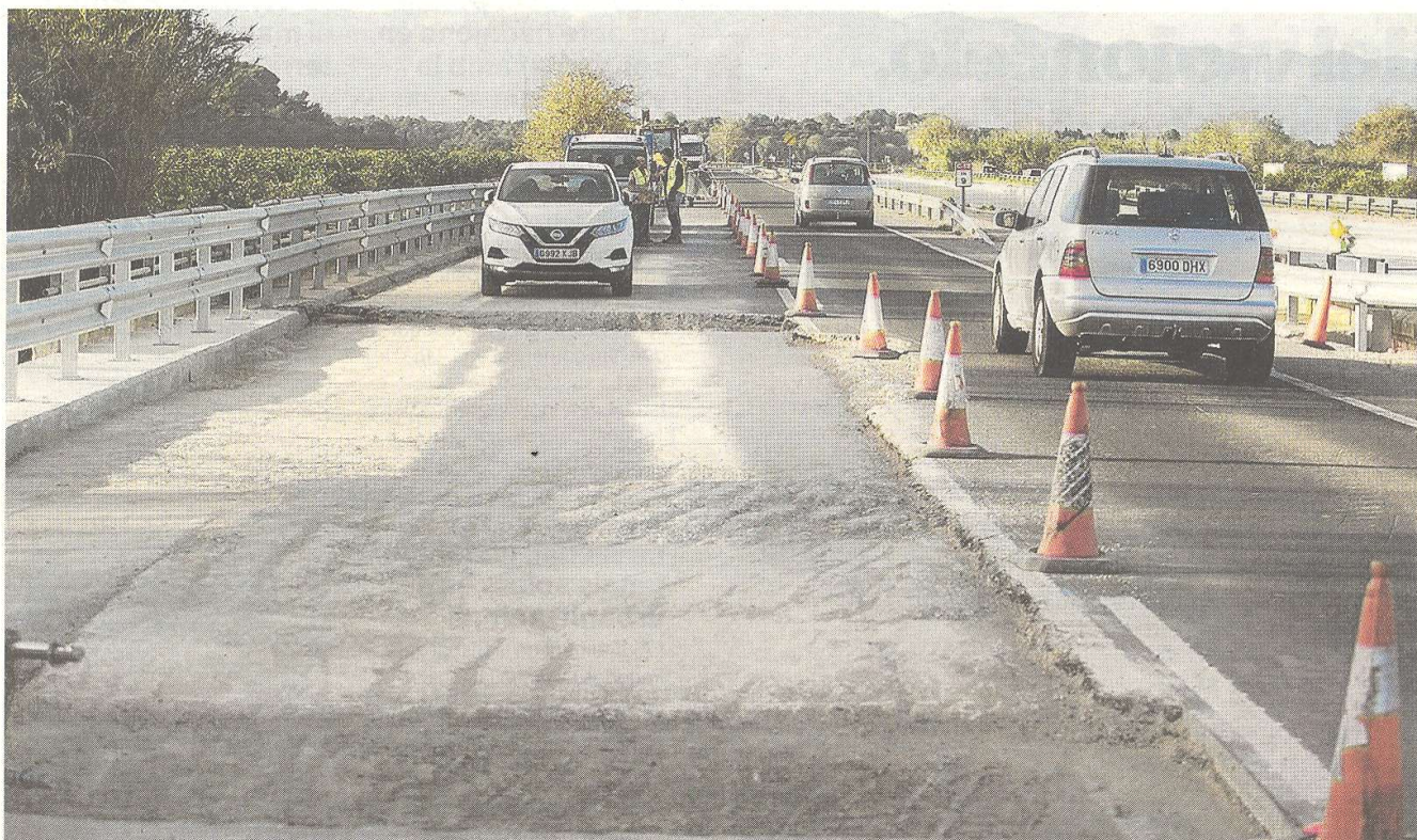
Reparació de la carretera C-12 al punt malmès entre Tortosa i Amposta, ahir. FOTO: JOAN REVILLAS
