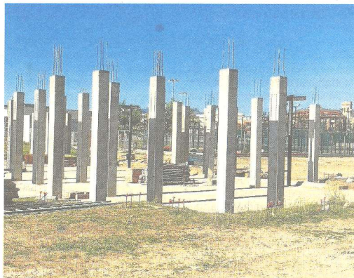
Imatge de les obres del nou pavelló poliesportiu. FOTO: JOAN REVILLAS
