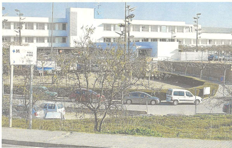
Imatge exterior de l'Hospital de Móra d'Ebre. FOTO: JOAN REVILLAS
