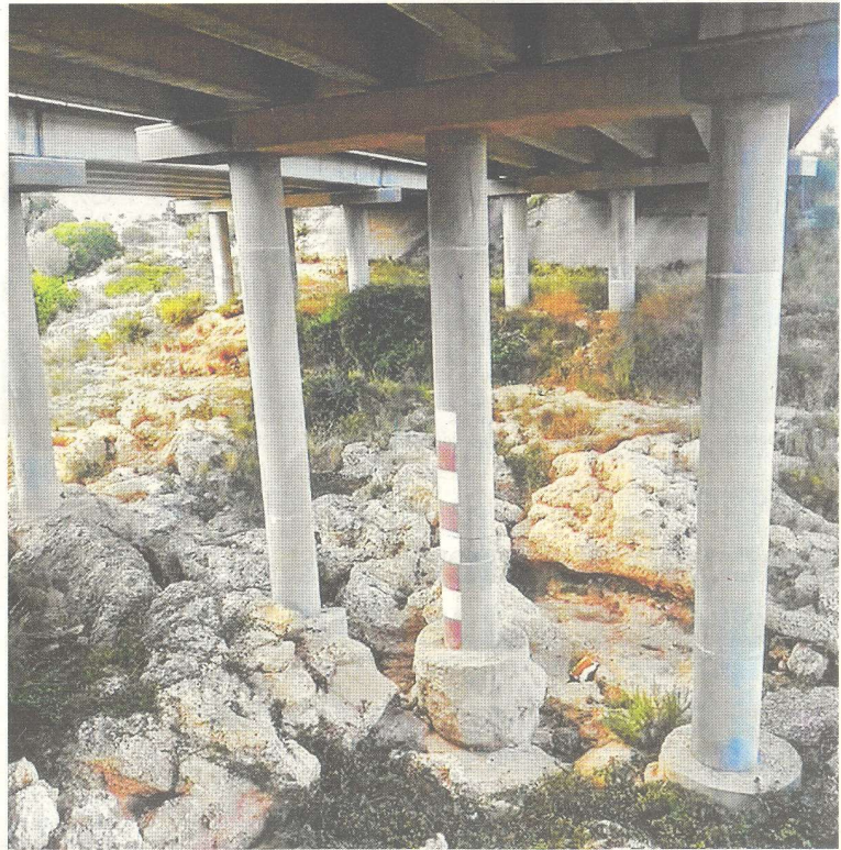
Imatge del pont sobre el barranc de Barbiguera, a Vinaròs. FOTO: CEDIDA
