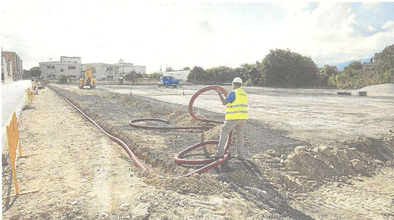
Imatge d'operaris treballant al nou aparcament en superfície i que serà gratuït, ahir. FOTO: JOAN REVILLAS
