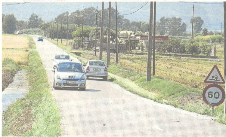
Estat actual de la carretera de la Ràpita al Poble Nou del Delta i el Trabucador. FOTO: JOAN REVILLAS
