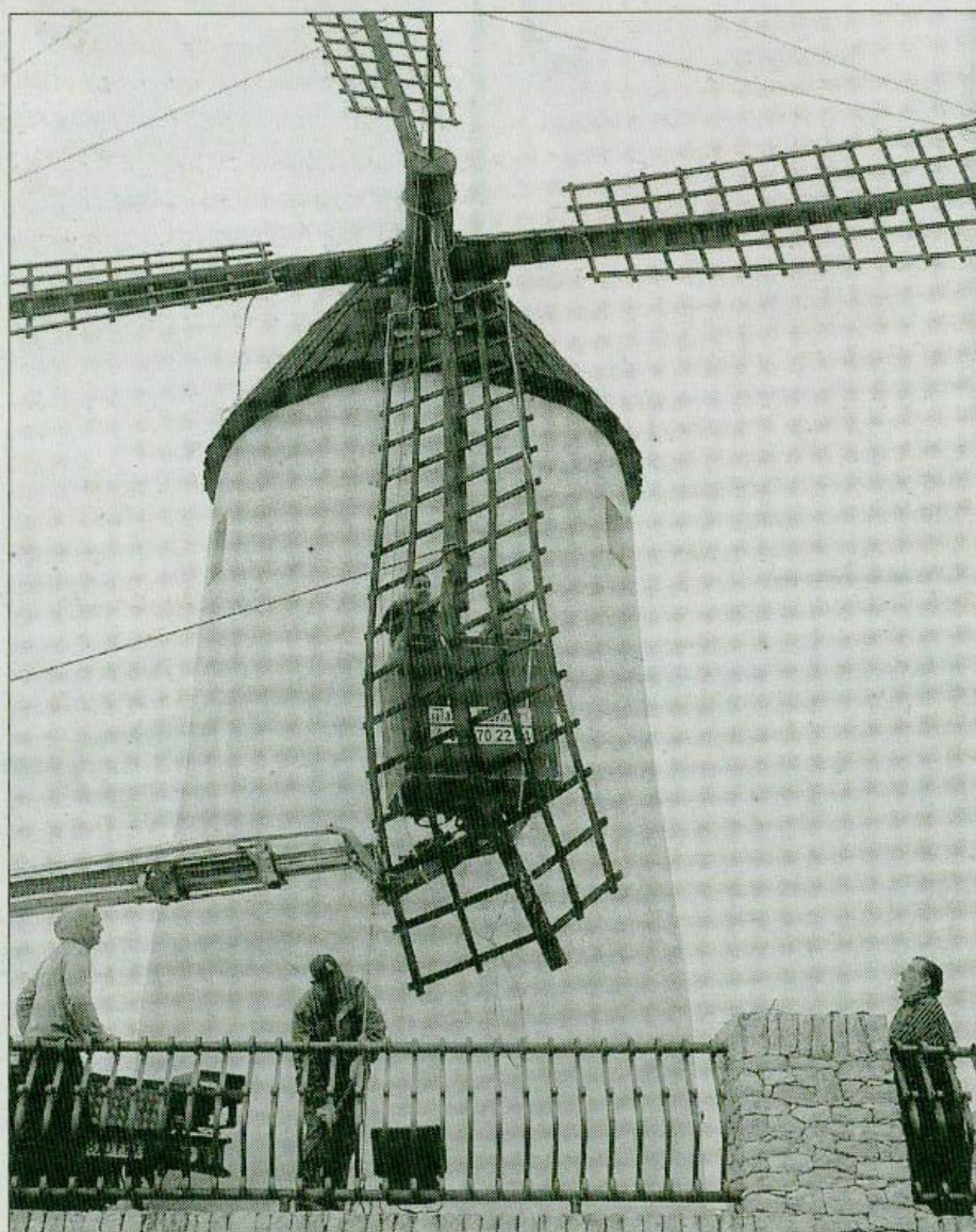
► Diversos operaris reparant una aspa del molí 'quixotes', ahir al matí, al municipi del Perelló. FOTO: JOAN REVILLAS
