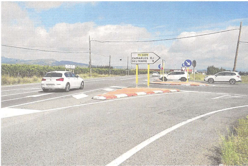
Punt de la carretera N-340 al terme municipal de Camarles, on es preveu construir una de les noves rotondes. FOTO: JOAN REVILLAS
