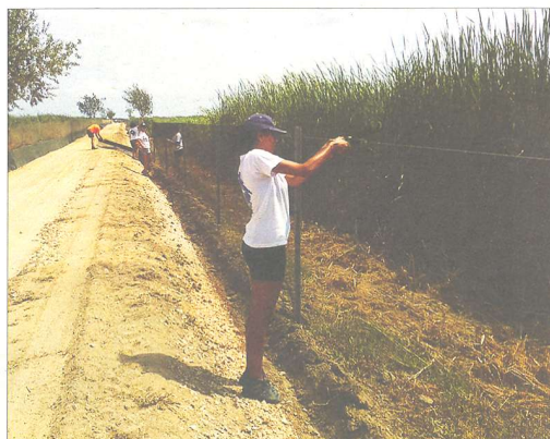
Imatge de la tanca perimetral que han estat construint voluntaris del Parc i treballadors de Forestal Catalana. / CEDIDA
