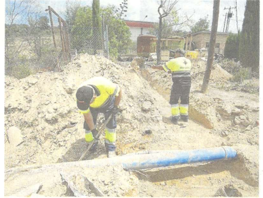
Obres per instal·lar els filtres de carbó actiu. FOTO: JOAN REVILLAS
