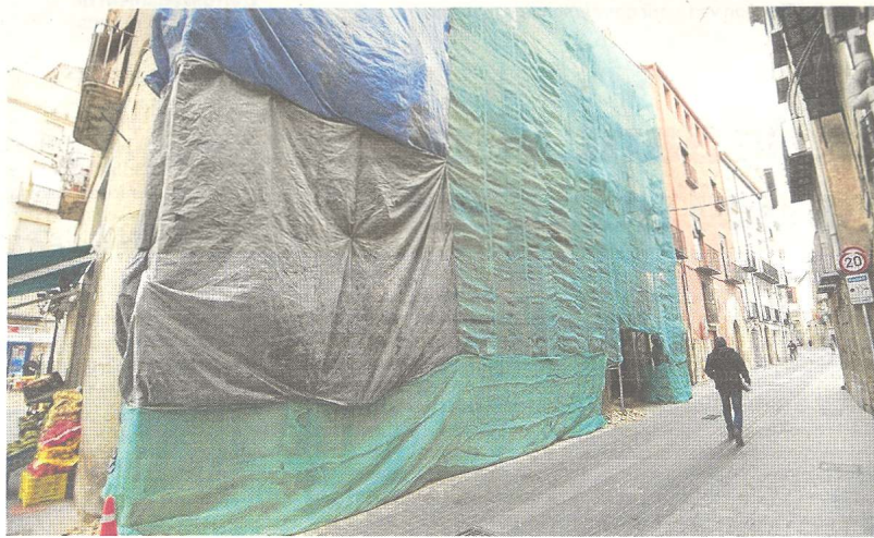
Imatge d'una façana en rehabilitació al carrer Montcada, l'hivern passat. FOTO: JOAN REVILLAS
