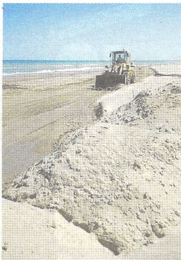
Les màquines treballant a l'illa de Buda. FOTO: JOAN REVILLAS
