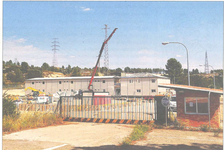
La caserna per a la Guàrdia Civil, durant la seua construcció dins de les instal·lacions de la nuclear. / A.P.
