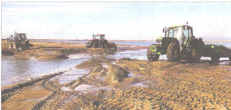
A dalt, imatge de la via d'aigua oberta a la barra litoral dels calaixos de Buda el dimarts dia 13. A sota, dimecres dia 14, es va dur a terme una acció de reparació del cordó de sorra per a evitar la intrusió marina a la llacuna. / NÚRIA CARO / CEDIDA
