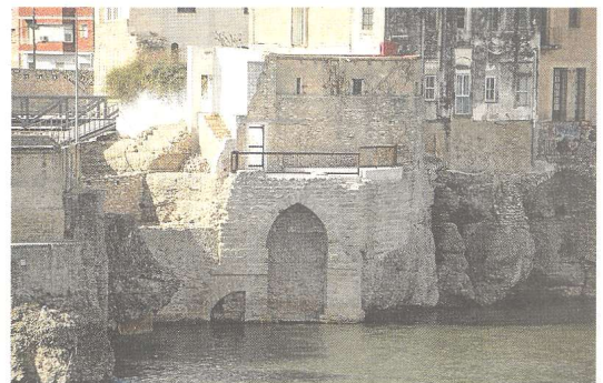
Arcada restaurada durant la primera fase dels treballs, ja executats. FOTO: JOAN REVILLAS
