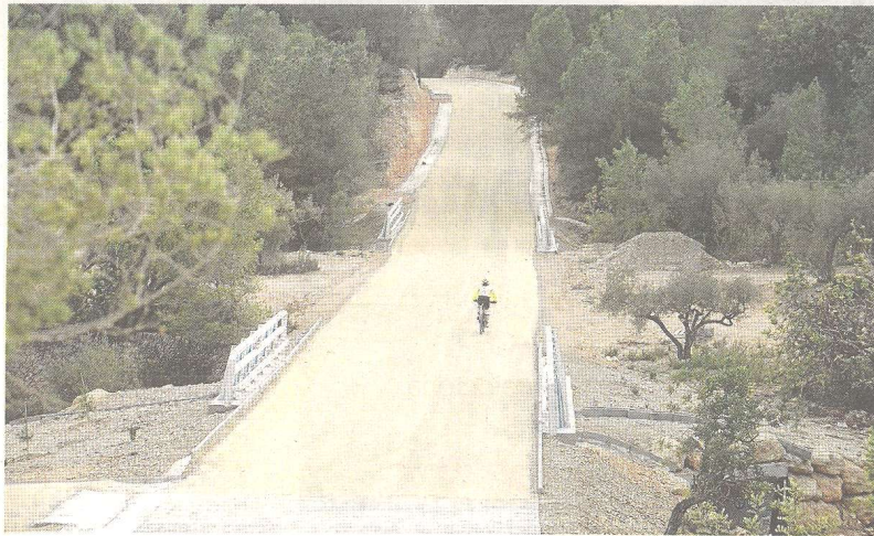
Imatge de la carretera, ahir al matí, que rebrà un doble tractament asfàltic. FOTO: JOAN REVILLAS
