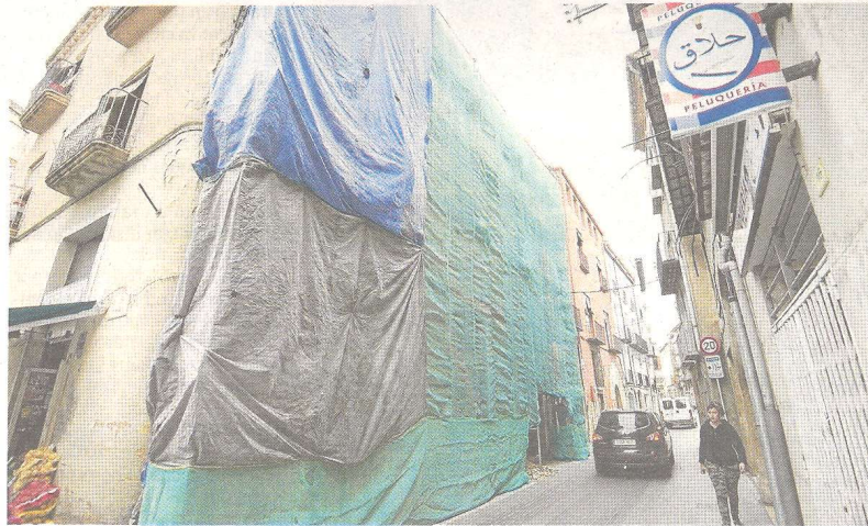
Imatge d'una rehabilitació d'una façana del carrer Moncada, aquesta setmana. FOTO: JOAN REVILLAS
