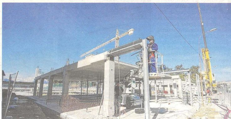
Les obres de la nova piscina de Tortosa. FOTO: JOAN REVILLAS
