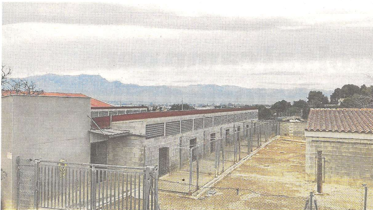
Aquest era l'aspecte ahir al matí de les instal·lacions de la gossera, completament buida. FOTO: M. PALLÁS
