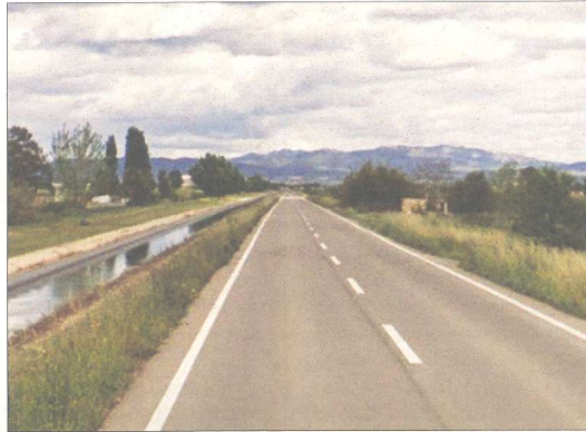
Imatge de la carretera TV-3408 que unix Amposta i la Ràpita. / L'EBRE
