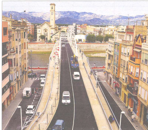
Les obres del pont de Tortosa van allargar-se un any i mig. / NÚRIA CARO
