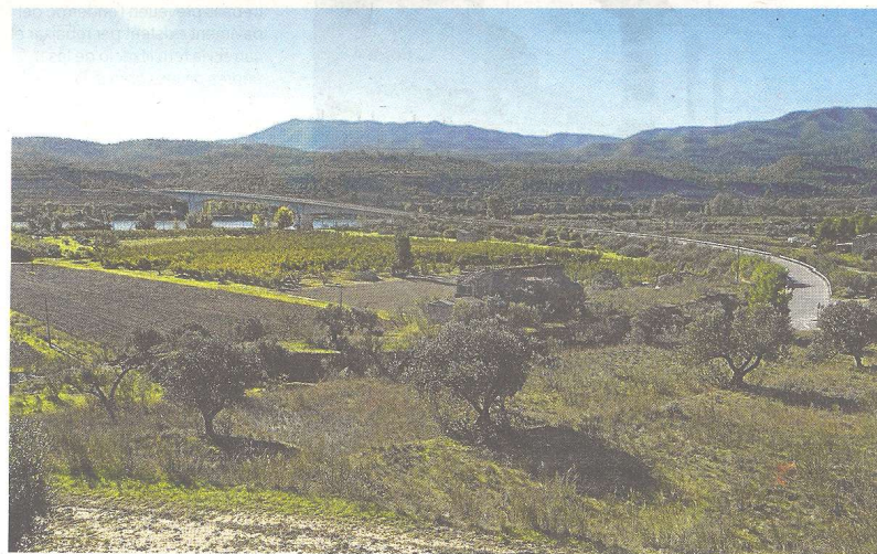
El pont del municipi porta vint anys construït i desemboca en una pista de terra. FOTO: JOAN REVILLAS
