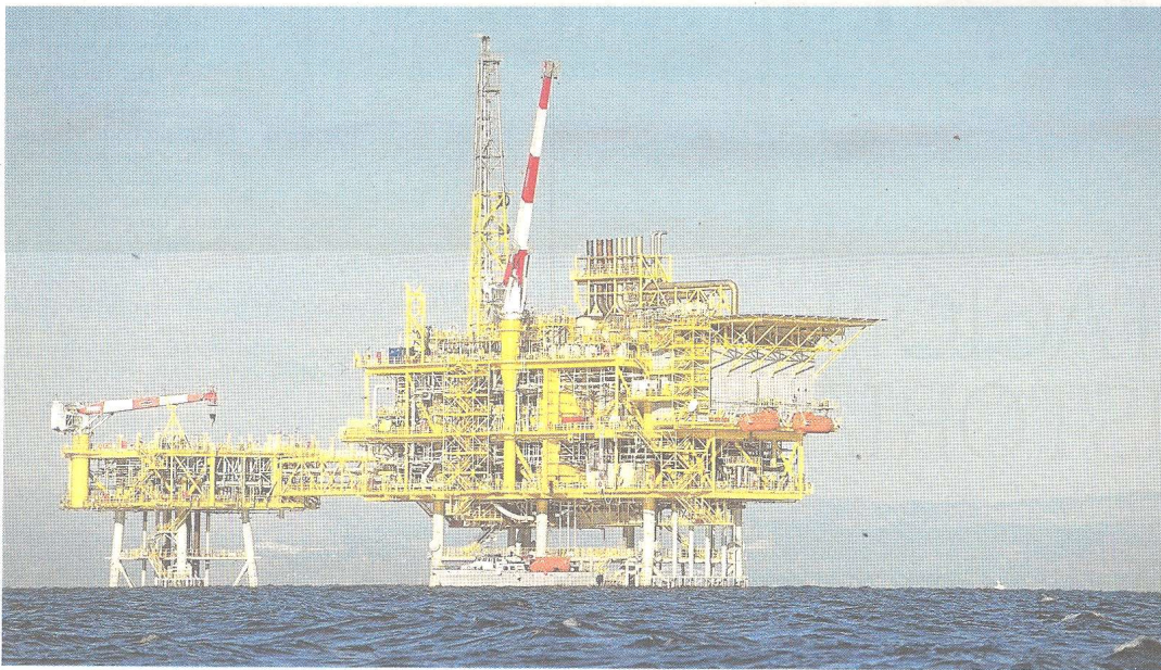
Imatge del magatzem de gas que durant el 2013 va causar centenars de sismes registrats a les costes de Castelló i l'Ebre. FOTO: JOAN REVILLAS
