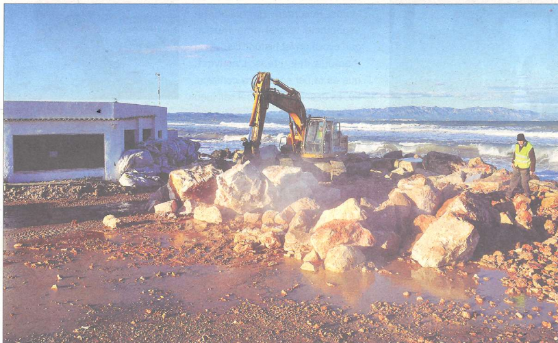
Aquest dimecres, les màquines treballaven a la zona de la Marquesa per restaurar l'escullera. / N. CARO
