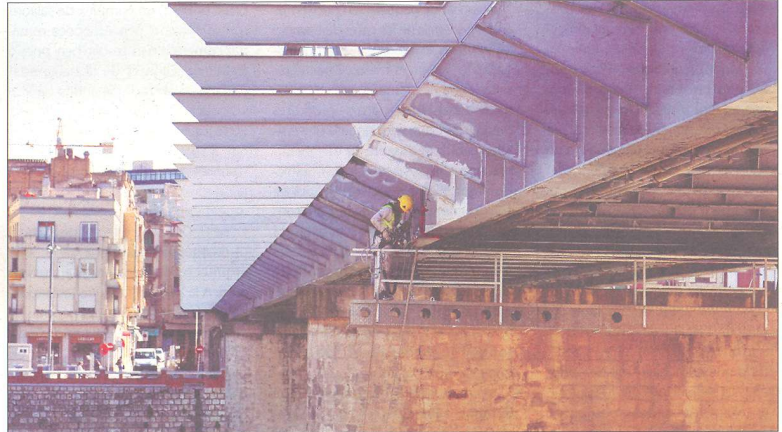
Imatge recent dels treballs a foc lent al pont de l'Estat de Tortosa. / N.C.
