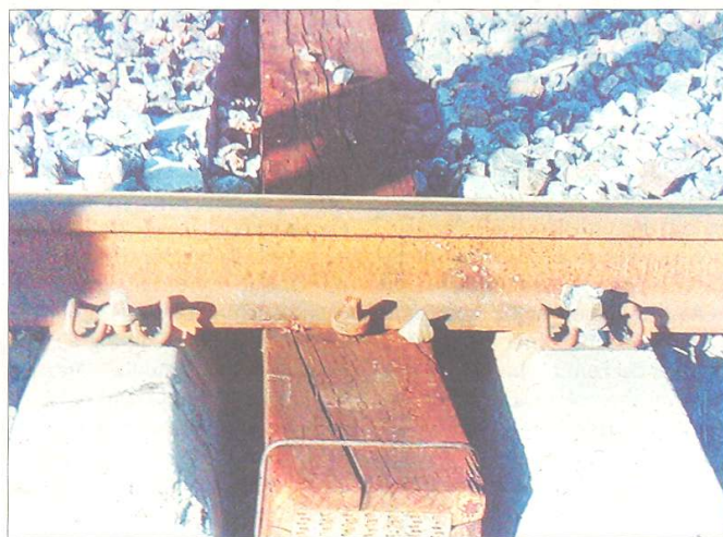
Una travessa de fusta, al tram entre Garcia i Ascó. / CANAL TE
