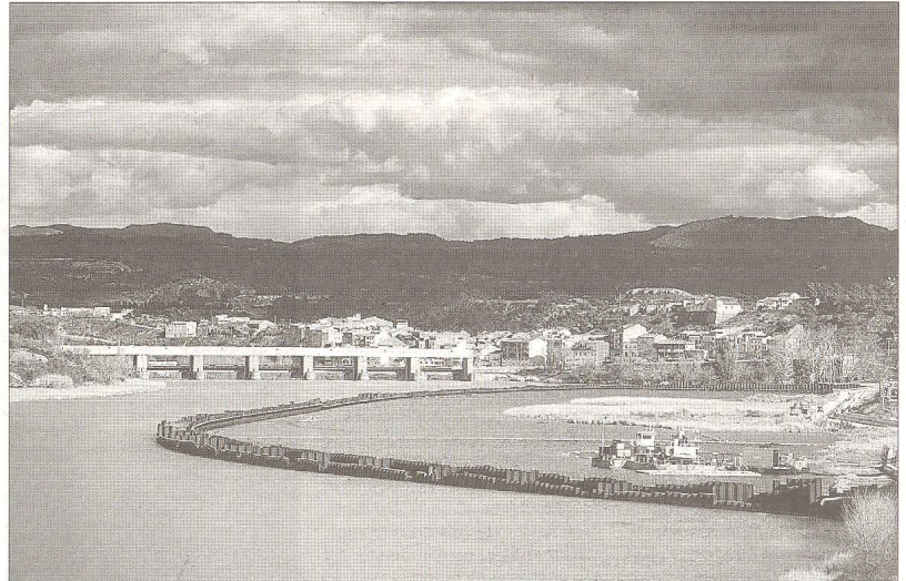
Imatge del mur de contenció aixecat fa anys per aïllar la zona contaminada. FOTO: JOAN REVILLAS
