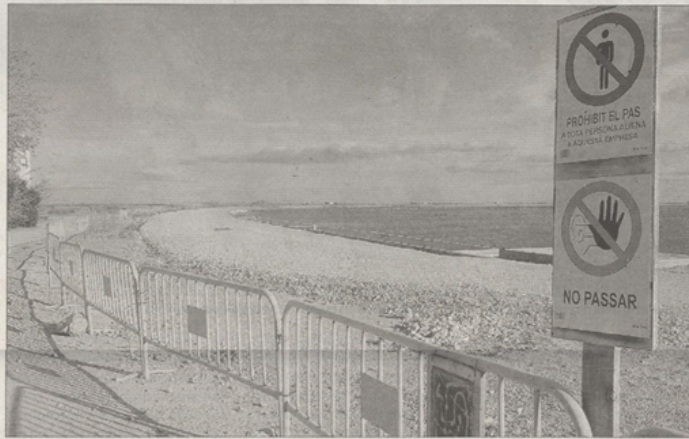
Obres dels filtres verds i reforma del litoral, a l'interior de la badia del Fangar. FOTO: JOAN REVILLAS
