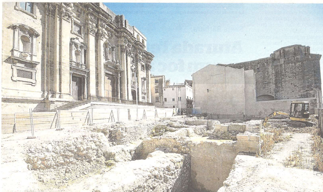
La urbanització de la plaça situada davant la façana de la Catedral i damunt de les excavacions, prioritat per al 2018. FOTO: JOAN REVILLAS
