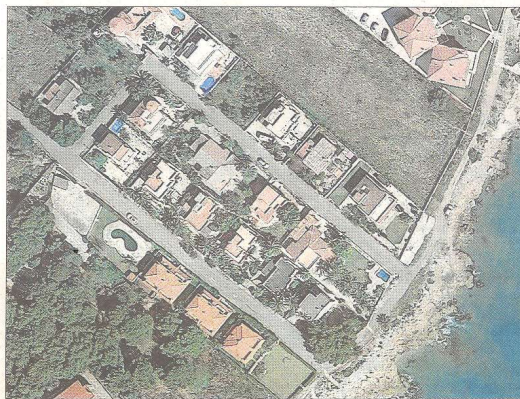
Imagen de satélite de la calle Martinenca B (la de la izquierda), en la que se produjo la brutal explosión ayer hacia las 23.30 horas.
