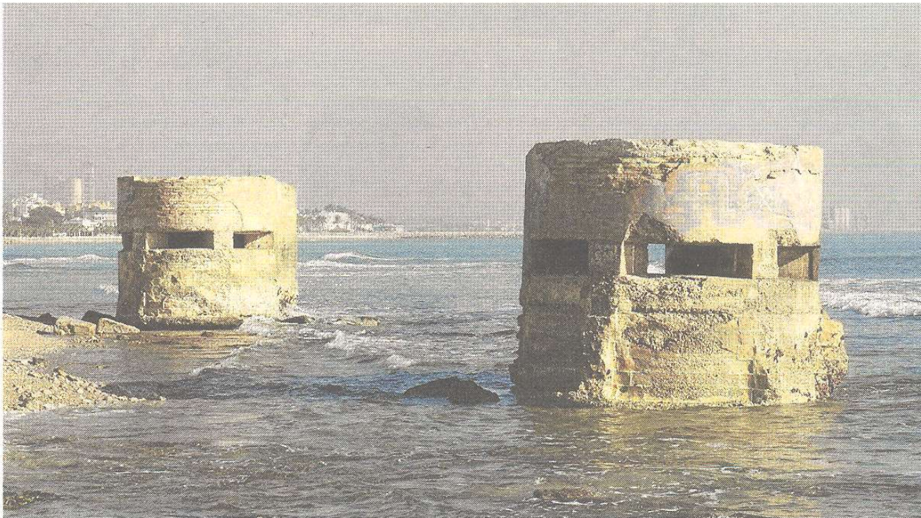
Els dos búnquers de la platja de l'Estanyat, a les Cases d'Alcanar. FOTO: JOAN REVILLAS
