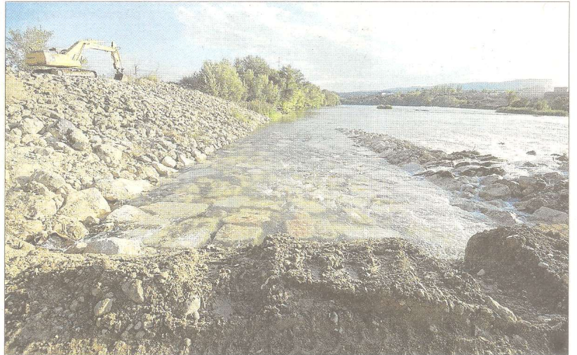
La rampa en construcció a l'assut d'Ascó, ahir a la tarda. FOTÓ: JOAN REVILLAS
