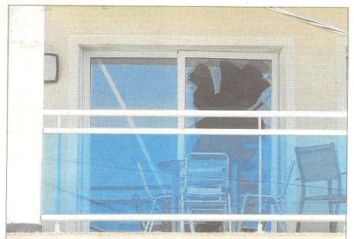
Un vidre trencat d'un xalet de l'entorn a la zona de l'explosió, ahir al migdia. FOTO: JOAN REVILLAS
