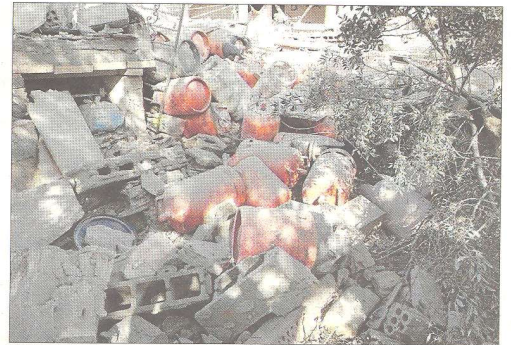
Acumulació de bombones de gas a les runes de la casa ensorrada, ahir al matí. FOTO: R. L./DT
