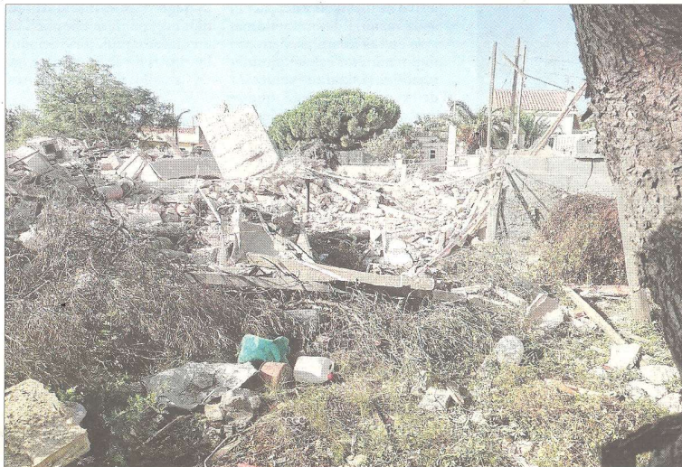
Imatge de les runes de la casa, completament ensorrada. FOTO: R.L./DT
