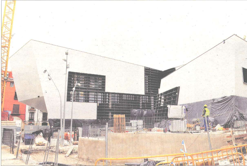
El nou edifici de les delegacions ha generat un nou espai públic en forma de plaça entre els carrers Montcada, Benasquer i Cabanes al nucli antic. / N.CARO
