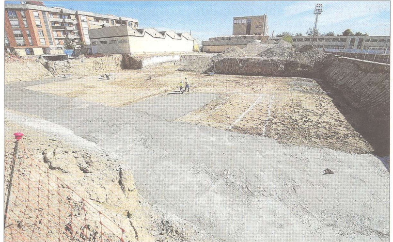
Imatge de les obres de les noves piscines de Tortosa, ahir a la tarda. FOTO: JOAN REVILLAS
