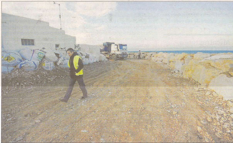
La construcció d'una escullera de protecció ha costat 70.000 euros. FOTO: JOAN REVILLAS
