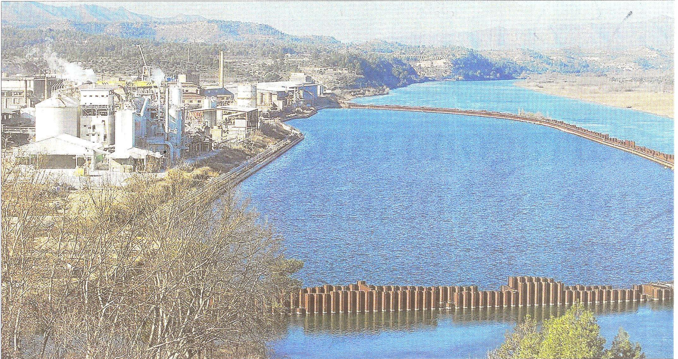
Estado actual del cercado en el pantano de Flix, frente a las instalaciones de Ercros. FOTO: JOAN REVILLAS
