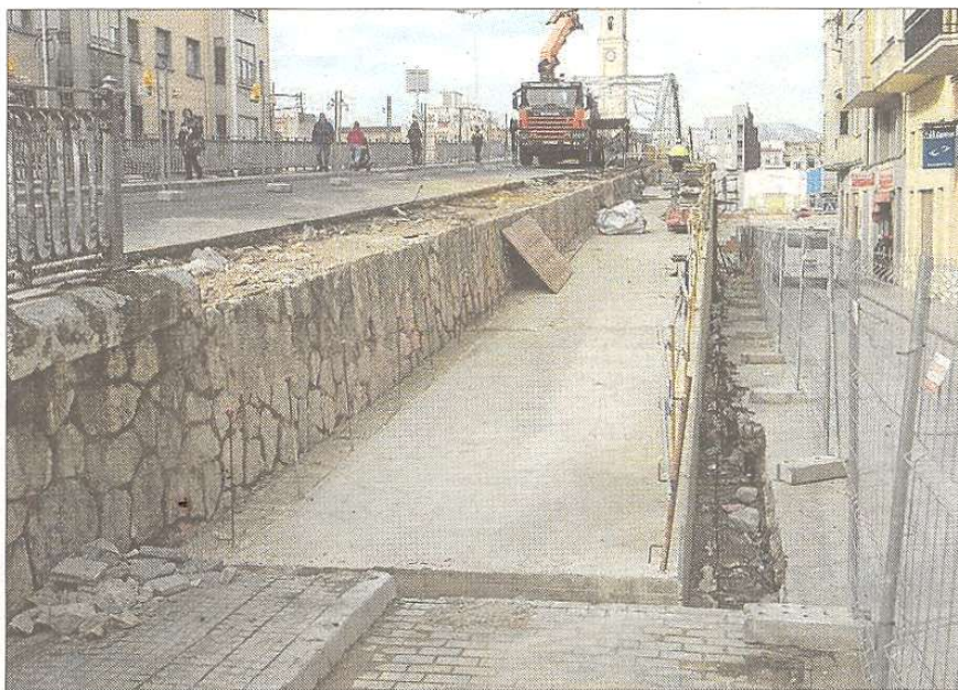
La rampa que s'està construint aquesta setmana a la banda nord del pont. FOTO: JOAN REVILLAS
