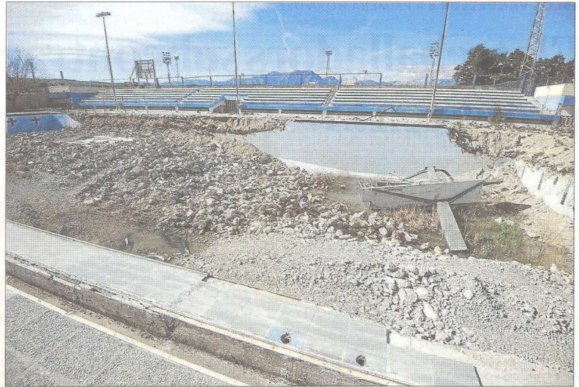
Estat actual de les piscines a l'Estadi Municipal, enderrocades el 2011. FOTO: JOAN REVILLAS
