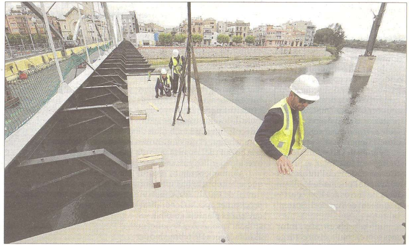
Els operaris instal·lant la passarel·la, ahir a la tarda, al pont de l'Estat de Tortosa. FOTO: JOAN REVILLAS
