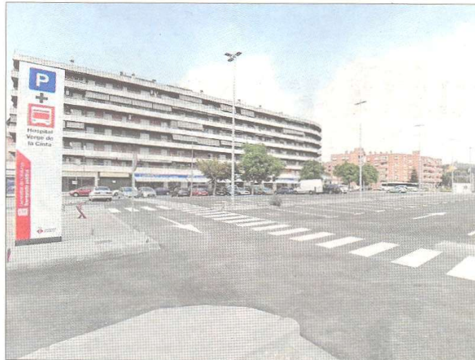
L'aparcament disposa d'un total de 118 places en superfície, a un dels principals accessos a la ciutat. FOTO: JOAN REVILLAS
