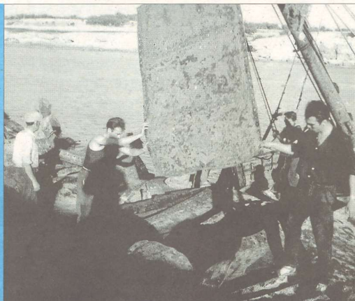
Feines molt dures i arriscades. Es feia servir dinamita per desprendre les planxes de ferro. FOTO: CEDIDA
