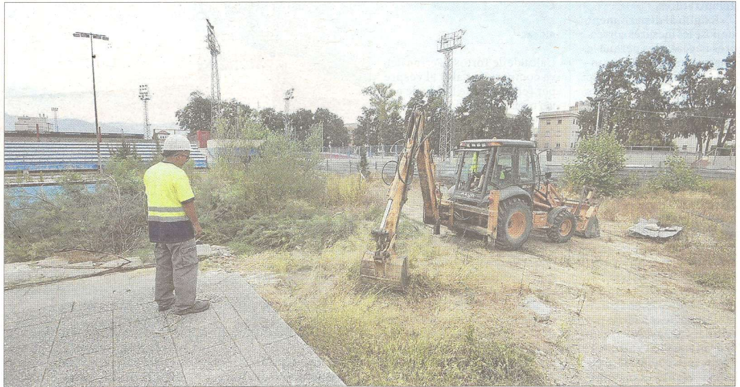
Una excavadora de l'empresa Benito Arnó e Hijos, ahir, en el primer dia de treballs del nou complex de piscines de Tortosa. FOTO: JOAN REVILLAS
