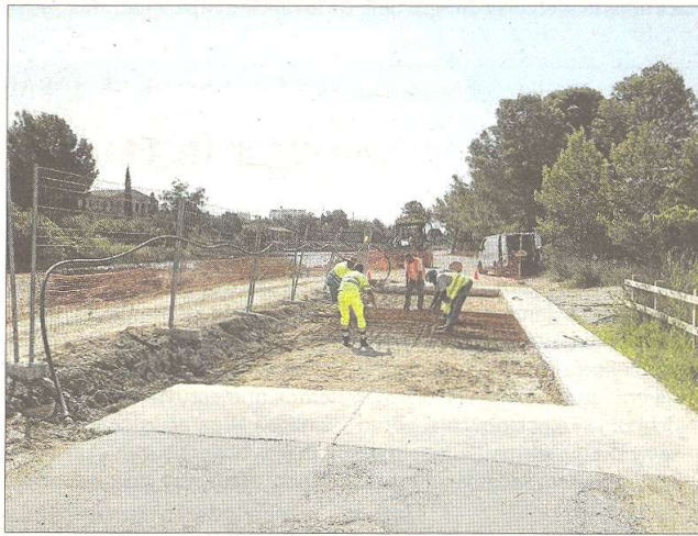
Operaris treballant en la zona propera a la llacuna litoral, on a la primavera es van alliberar samarucs. FOTO: JOAN REVILLAS
