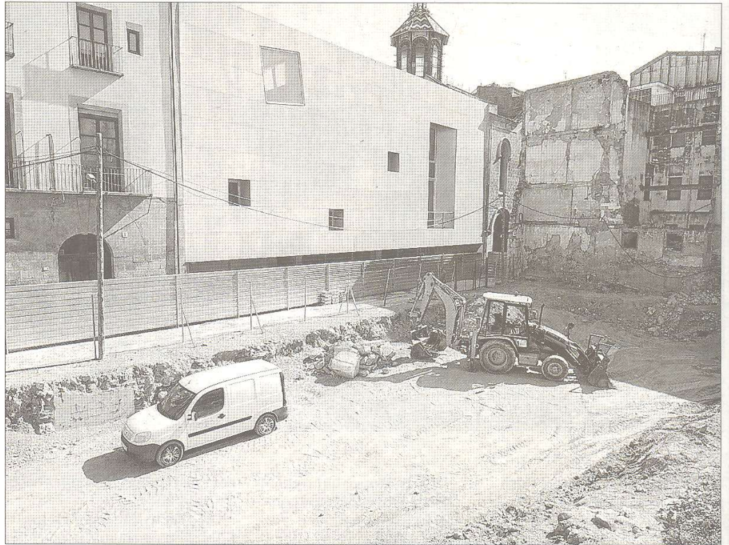
Primers treballs al solar del nou palau de justícia. FOTO: JOAN REVILLAS
