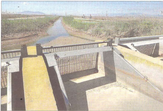
Instal·lacions a la zona de l'Illa de Mar, vora la badia del Fangar al terme municipal de Deltebre. FOTO: JOAN REVILLAS
