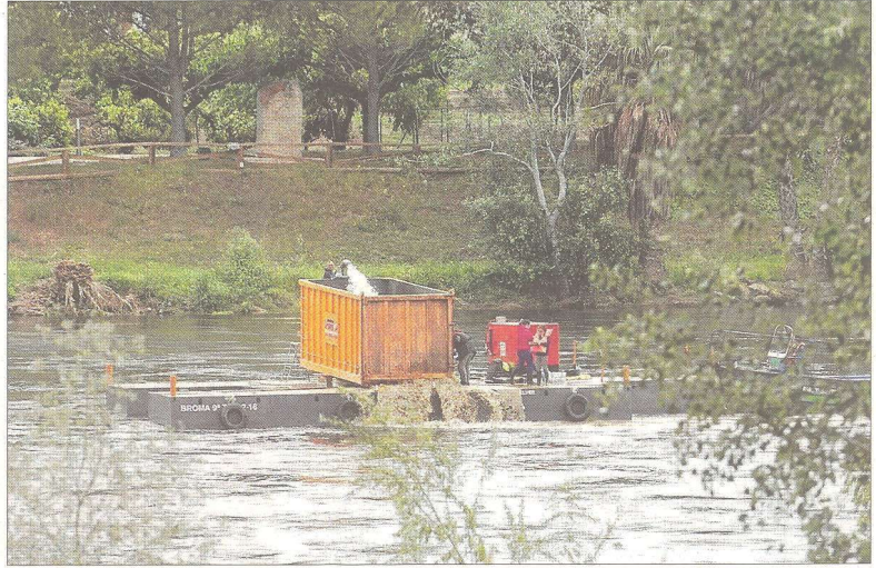
Plataforma des de la qual s'abocava la sorra barrejada amb aigua, a Benifallet. FOTO: JOAN REVILLAS
